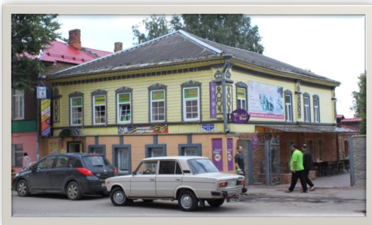
Бывшее здание лаборатории город Боровичи, ул. Подбельского д.11 (2023 г)
